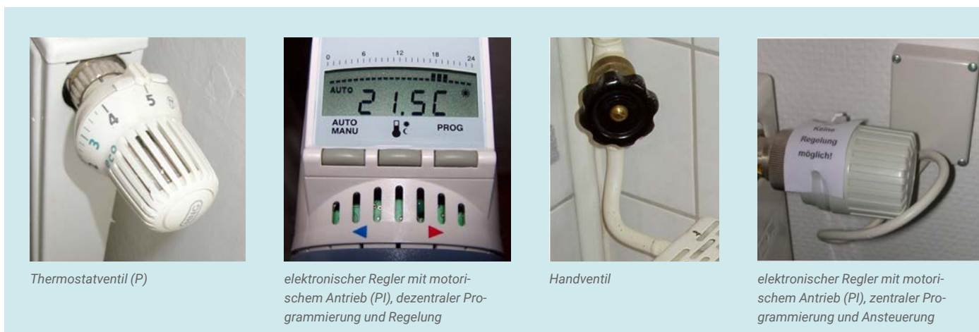
Abb. 28: Regler für Heizkörper
