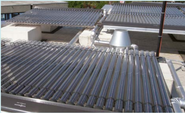
Vakuurröhrenkollektor
