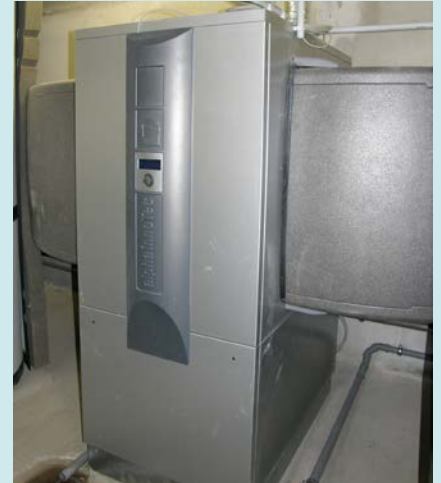
Außenluft-Wärmepumpe
