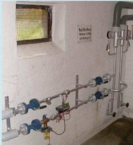
direkte Übergabe ohne Wärmeübertragung (nur Heizung)
