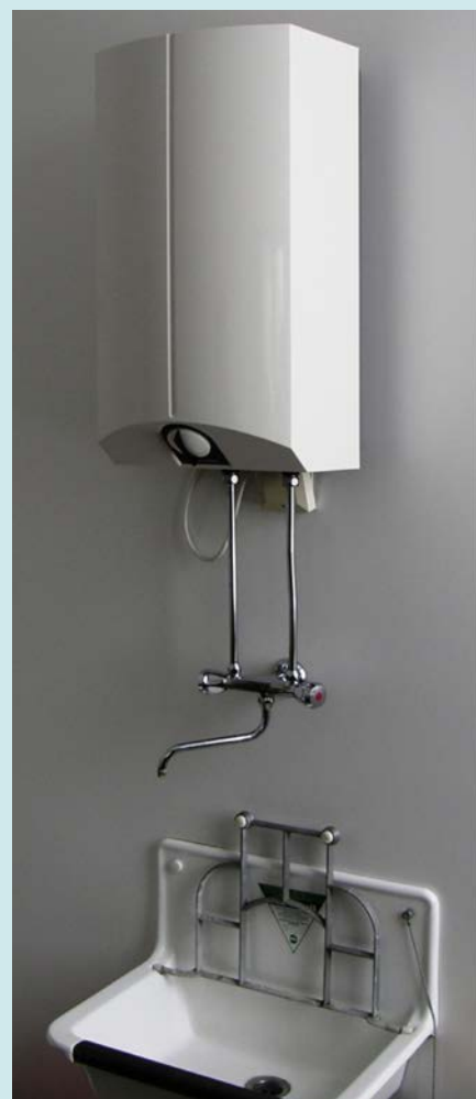
Elektrokleinspeicher (5 Liter)
