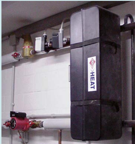
indirekte Übergabe mit Wärmeübertragung (nur Heizung)
