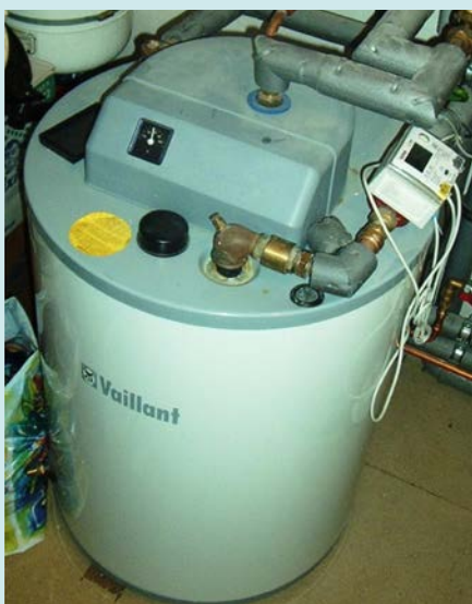
zentraler Warmwasserspeicher
