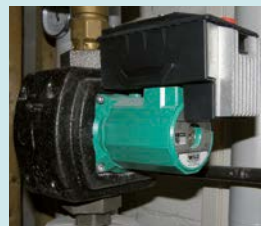
Regelpumpe, neuere Bauart (mit Display, hier: 30–200 W)
