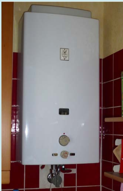
Gasdurchlaufwassererwärmer
