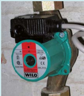
einstufige Zirkulationspumpe (hier: 46 W)
