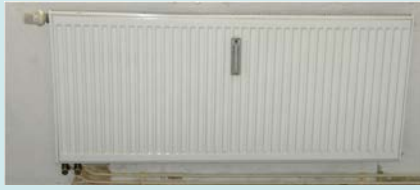
Plattenheizkörper
