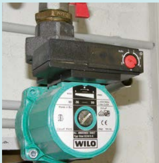
Regelpumpe, ältere Bauart (ohne Display, hier: 36–99 W)
