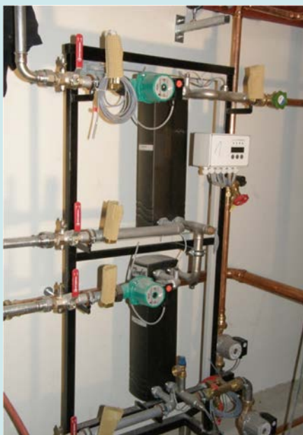
Durchlaufwassererwärmung mit Wärmeübertrager
