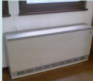
Elektrospeicherheizung
