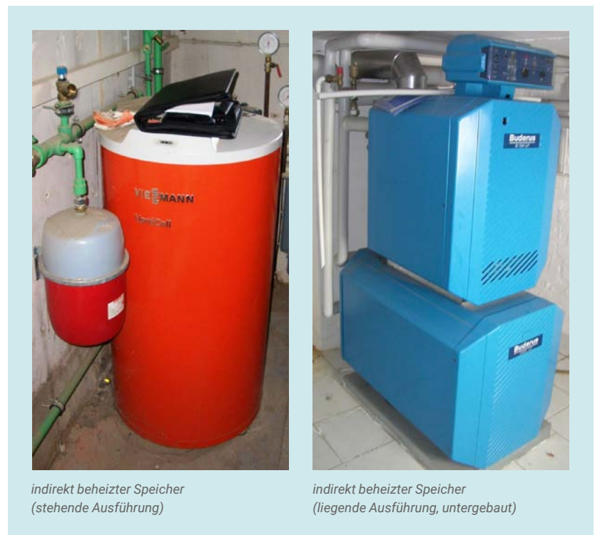
Abb. 39: Liegender und stehender Trinkwarmwasserspeicher
