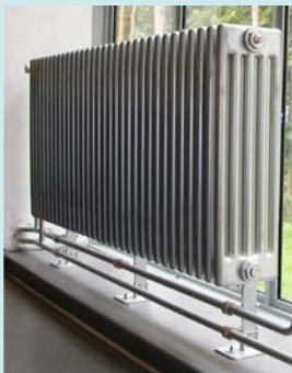
Stahlradiator (vor Glasfläche, ohne Strahlungs-schutz)
