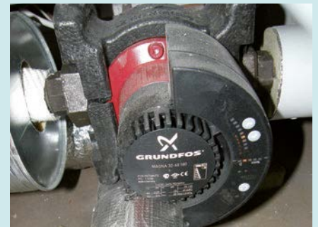
Hocheffizienzregelpumpe, neueste Bauart (per Funk fernprogrammierbar und auslesbar, hier: 10–85 W)
