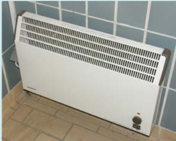
Elektrodirektheizungen
